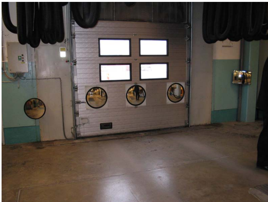
Inne i besiktningshallen.
